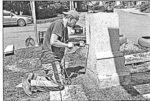
Rozsáhlou opravu křížku realizovalo Kamenosochařství Bulička Kostníky. Foto: Luboš Janoušek
